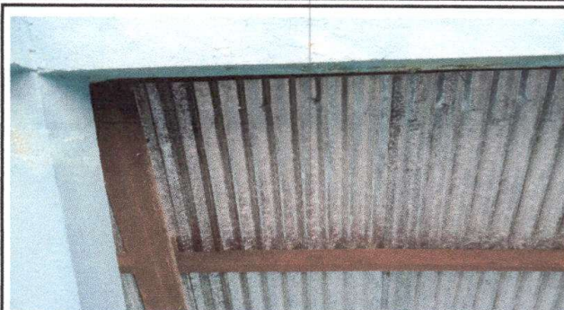
Foto 2: Sustitución de techo Lamina y estructura Modulo 1 de madera por metal.
