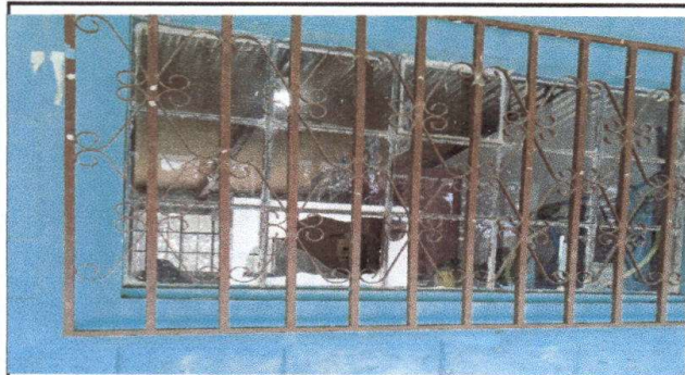
Foto 1: Pintura de interior y exterior
