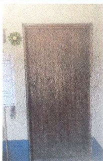
Foto 9: Cambio de chapa y puerta de madera por metal
