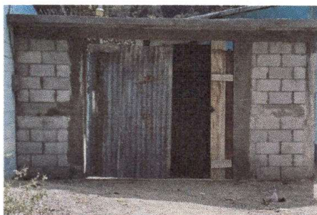
Foto 7: Sustrucción de portón de ingreso y repello de muro
